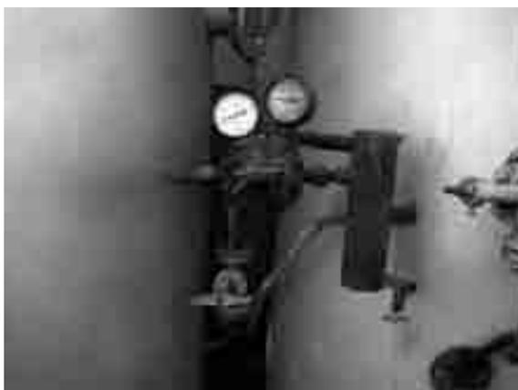
Рис.36. Регулятор давления газа.
