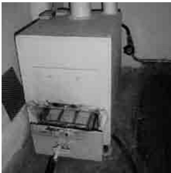
Рис.35. Водонагревательный котел для отопления дома с излучающими керамическими нагревателями в с. Петровка.
