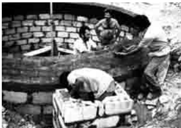
Рис.16. Сооружение кирпичного реактора на Кубе.
