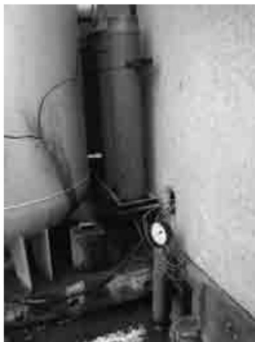
Рис.23б. Стальные газгольдеры высокого давления в с. Петровка.
