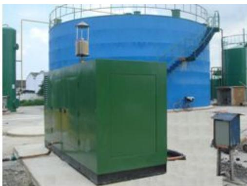
*При контейнерном исполнении когенераторов не нужны любые строительные работы для подготовки посадочного места*
